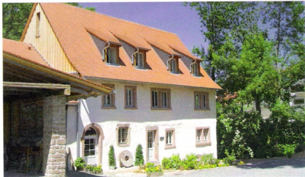
Die Fondsbroker AG wollte nicht länger im typischen Finanzdienstleister-Glaspalast residieren. 2005 ist sie daher in die Apfelbachmühle in Hirschberg gezogen. Zuvor wurde die 680 Jahre alte Mühle aufwendig saniert. Bilder: Fondsbroker AG
